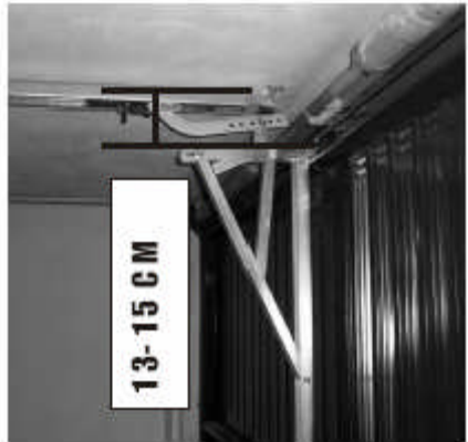
Fije la palanca del carro al brazo telescópico, utilizando el 3° o 4° orificio de la palanca.
