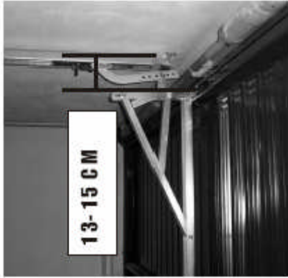
Ancorare la leva del carrello al braccio telescopico utilizzando il 3° o 4° foro della leva.
